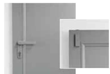
Stangenschloss (eingebaut)
